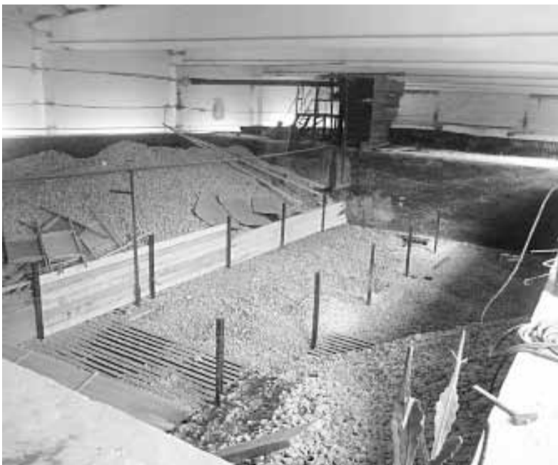
На очистных сооружениях в Кедровом начались работы по заполнению второго биофильтра
